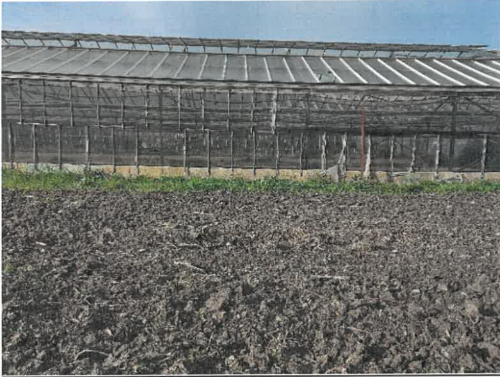
Photo 3 : Serres chapelles côté Est.
