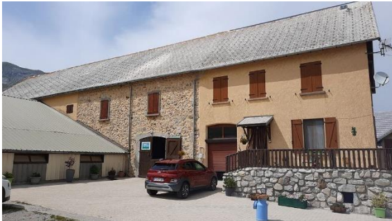
Bâtiment habitation et grange
